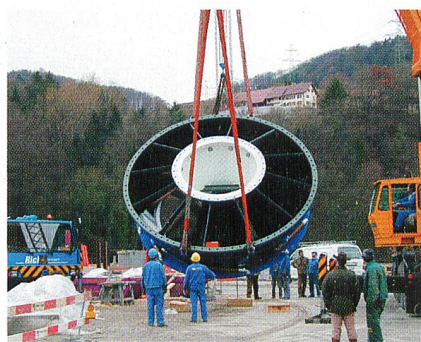
Montage des Turbinen-Leitapparats.
