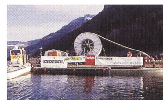
Verlegung eines 5000 Meter langen 16-kV-Kabels im Thunersee.
