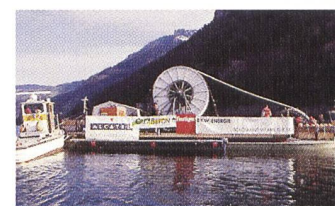
Verlegung eines 5000 Meter langen 16-kV-Kabels im Thunersee.
