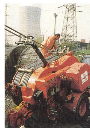
Bauarbeiten an einer 380-kV-Hochspannungsleitung.
