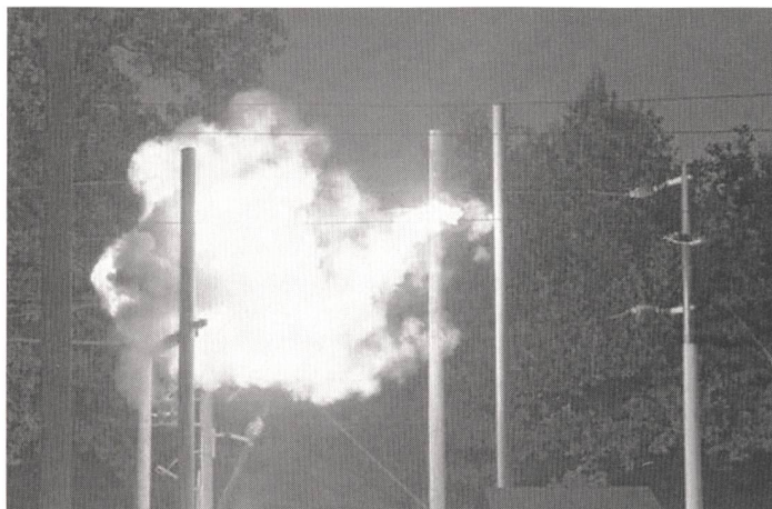
Mise à terre bricolée (Photo: CEF).
