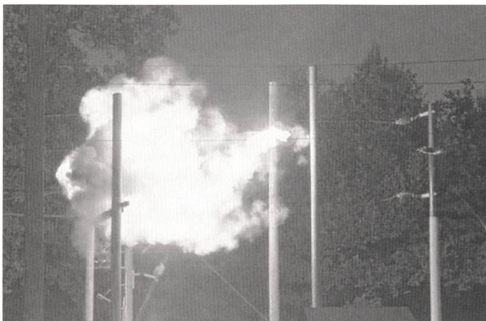
Mise à terre bricolée (Photo: CEF).
