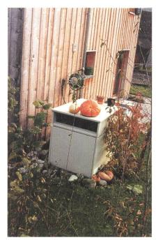
Bild 3 Luft-Wasser-Wärmepumpen sind klein, effizient und gewinnen wertvolle Heizenergie aus der Umgebungsluft (Foto: Claudia Müller).
