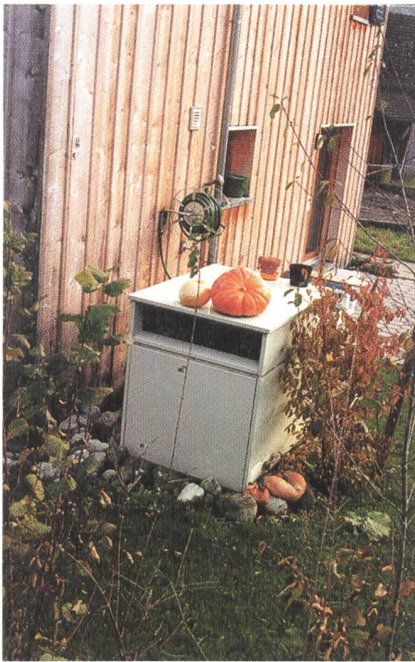
Bild 3 Luft-Wasser-Wärmepumpen sind klein, effizient und gewinnen wertvolle Heizenergie aus der Umgebungsluft (Foto: Claudia Müller).
