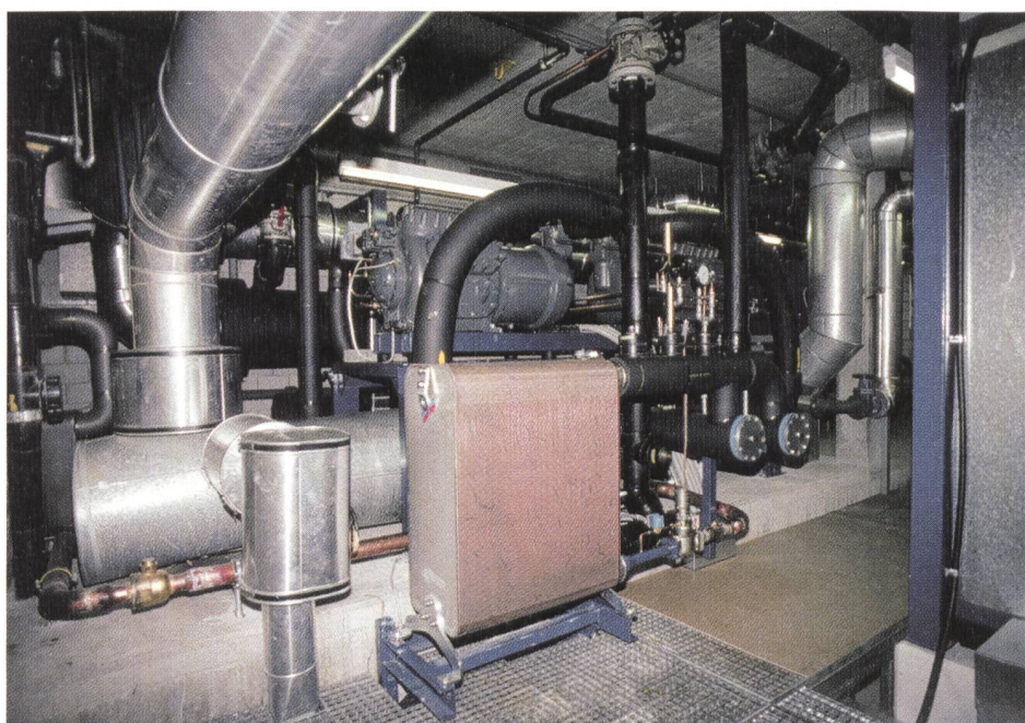
Bild 4 Grosse Grundwasser-Wärmepumpenheizung im Sportzentrum Aaretal (Foto: Franz Beyeler).
