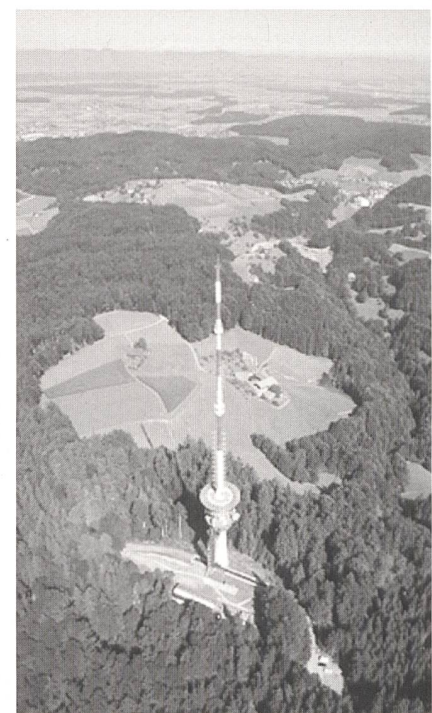
Bild 2 Sendeanlage der Swisscom auf dem Bantiger in der Nähe von Bern (Quelle: Swisscom)
