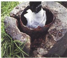
Bild 3 Freigelegter Korrosionsangriff im Sockelbereich.
