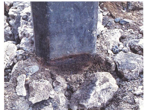
Bild 2 Freigelegter Korrosionsangriff im Erdeintrittsbereich.
