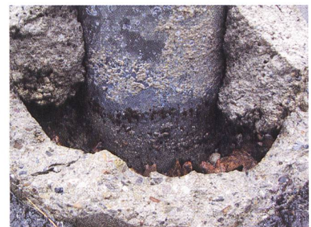
Bild 2 Freigelegter Korrosionsangriff im Erdeintrittsbereich.
