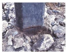
Bild 2 Freigelegter Korrosionsangriff im Erdeintrittsbereich.
