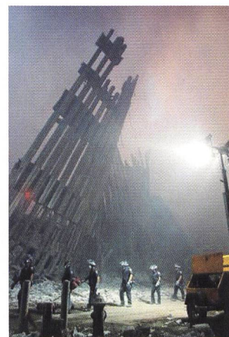
Arbeiten in den Trümmern des World Trade Centers.
