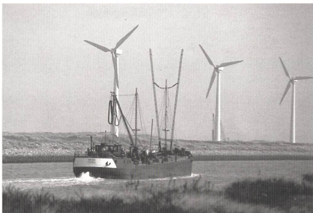
Grosser Windschub in Frankreich: Windkraftwerk bei Dünkirchen (Bild EdF).
