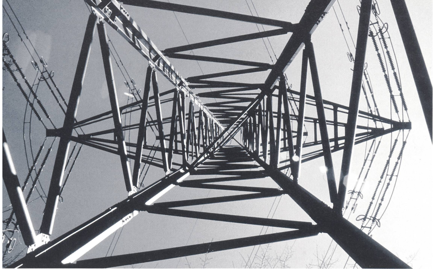
Beim Betrieb einer Freileitung entstehen elektrische und magnetische Feld- sowie Geräuschemissionen.
