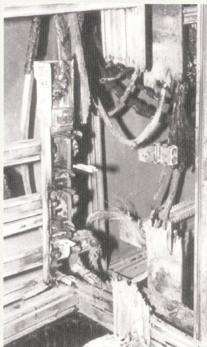
Brand durch Erdschluss in einer Elektrohauptverteilung. Auf den Boden tropfende verflüssigte Aluminium- und Kupferteile entzündeten anschliessend auch den Barackenboden. – Incident provoqué par un court-circuit dans un distributeur principal. L'aluminium et le cuivre liquides s'égouttant sur le sol ont ensuite mis le feu également au sol de la baraque.
