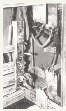
Brand durch Erdschluss in einer Elektrohauptverteilung. Auf den Boden tropfende verflüssigte Aluminium- und Kupferteile entzündeten anschliessend auch den Barackenboden. – Incendie provoqué par un court-circuit dans un distributeur principal. L'aluminium et le cuivre liquides s'égouttant sur le sol ont ensuite mis le feu également au sol de la baraque.
