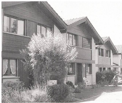
Bild 1 Die Hauseigentümer am Chemin des Pluviers bei Genf reduzierten ihre jährliche Stromrechnung mit dem Wechsel von dezentralen Elektroheizgeräten zur Wärmepumpenheizung um 2000 bis 3000 Franken. (Quelle: SIG)
