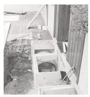
Bild 2 Die als Wärmequelle dienende Aussenluft wird im Eingangsbereich gewonnen und über wärmegedämmte Blechkanäle direkt zur Anlage im Keller geführt. Nach Abschluss der Arbeiten sind heute vom Luftein- und -auslass nur noch diskrete bodenebene Gitter beidseits der Eingangstür zu sehen. (Quelle: SIG)
