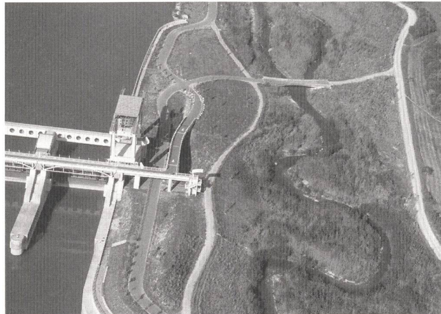
Ein 1,5 Kilometer langer Umgebungsbach erleichtert Fischen die Wanderung um das Wiener Donaukraftwerk Freudenau von Verbund, Österreichs grösstem Stromerzeuger und -transporteur.
