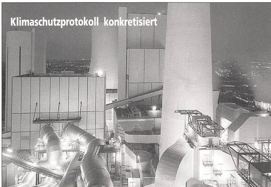
Selbstverpflichtung zum Klimaschutz: gezielte Rauchgasreinigung bei fossil gefeuerten Kraftwerken (Foto ize).
