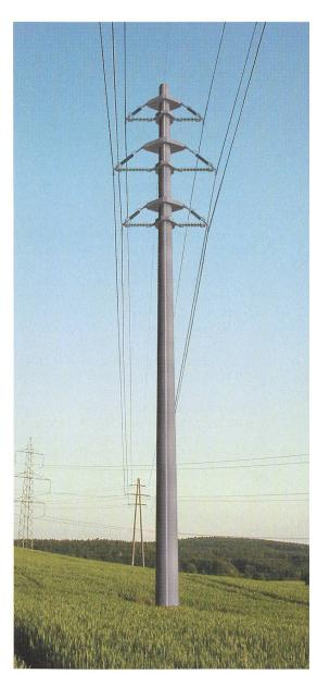
Erste mit Kohlenstofffasern bewehrte Betontragstruktur für 110-kV-Hochspannungsmast.
