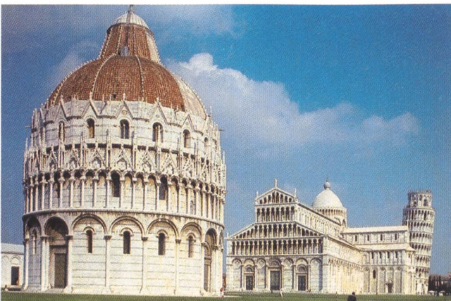
Bald bessere Luft in Italien durch sauberere Kraftwerke?
