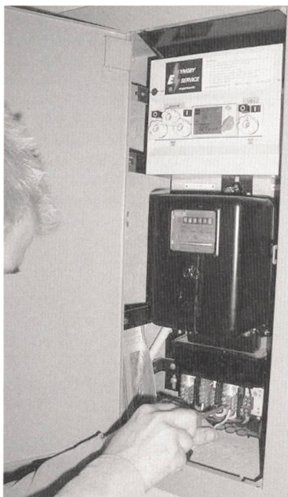
Bild 3 Indoor-Adapter Montage vor dem Zähler
