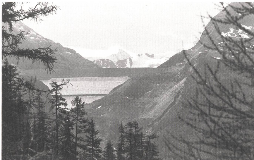
IWB sind mit 13 \frac{1}{3} % am Kraftwerk Grande Dixence beteiligt. Im Jahr 2000 waren, im Hinblick auf die Marktöffnung, weitere Abschreibungen nötig. (Bild: Germond)
