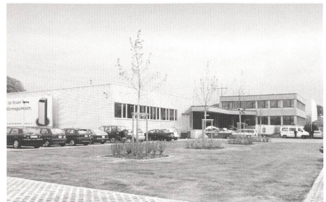
Betriebsgebäude der CTA in Münsingen.
