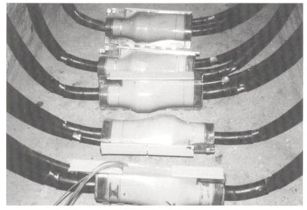
Bild 2 Niederspannungs-Abzweigmuffe
