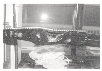
Bild 4 Schrumpfabzweigmuffe mit «Hosenklammer» als Abdichthilfe zwischen Durchgangsund Abzweigkabel
