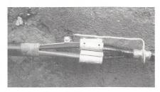
Bild 1 Kabelübergang Nakba (Masekabel, Papierölisolation) auf NAYY-(XLPE-)Kunststoffkabel vor Anlegen der Muffenschale
