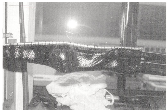
Bild 4 Schrumpfabzweigmuffe mit «Hosenklammer» als Abdichthilfe zwischen Durchgangs- und Abzweigkabel
