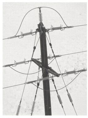
Bild 1 Abspannmast mit Verbundisolatoren aus dem beschriebenen Leitungsabschnitt
