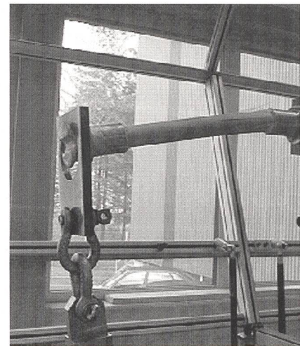
Bild 10 Bruchverhalten des Stützers
