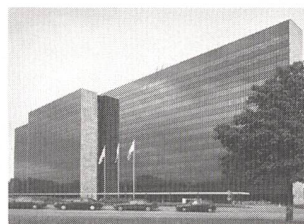
Hauptgebäude der HEW in Hamburg.
