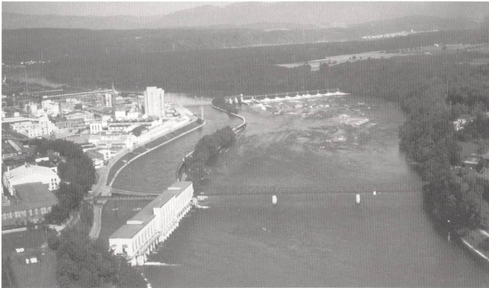
Wasserkraftwerk Rheinfelden soll neu gebaut werden.
