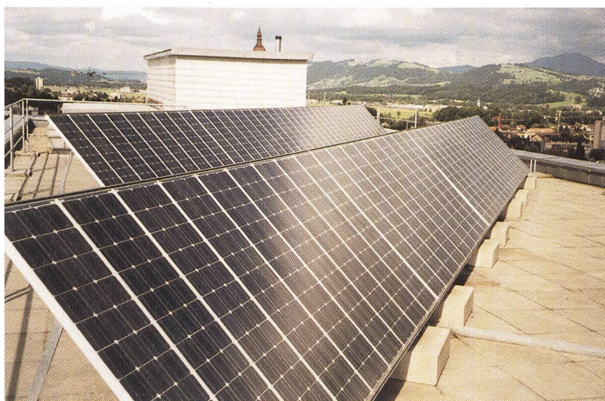
Bild 1 Photovoltaikanlage Alp Emmen, Aufständerung.
