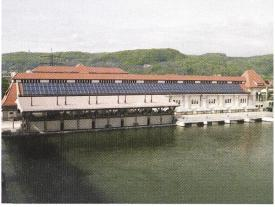
Titelbild: Ob auf dem Dach des eigenen Hauses oder in der Grossanlage im Megawattbereich: Photovoltaischer Strom hat gute Aussichten, in Zukunft wirtschaftlicher zu werden. Das Rheinkraftwerk Wyhlen verfügt über eine Leistung von 38 MW. Auf dem Dach wurde zusätzlich eine Photovoltaikanlage mit 70 kW Leistung errichtet (Photo NaturEnergie).
