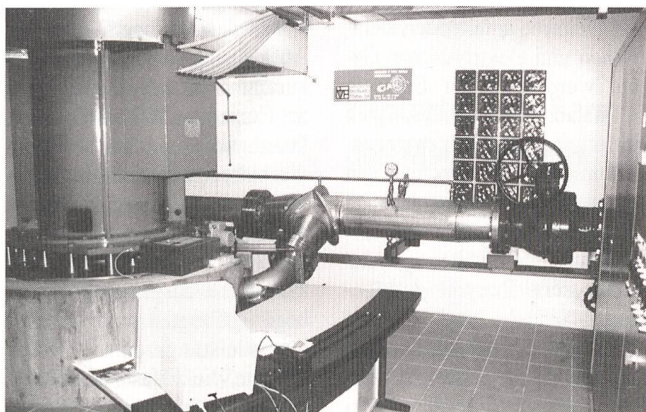
Zuleitung und Generator beim Trinkwasser-Verteilerreservoir La Rasse
