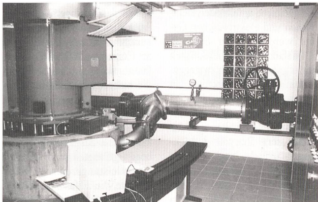
Zuleitung und Generator beim Trinkwasser-Verteilerreservoir La Rasse
