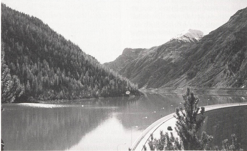
Livigno-Stausee mit der Staumauer Punt dal Gall: Hohe Produktion.
