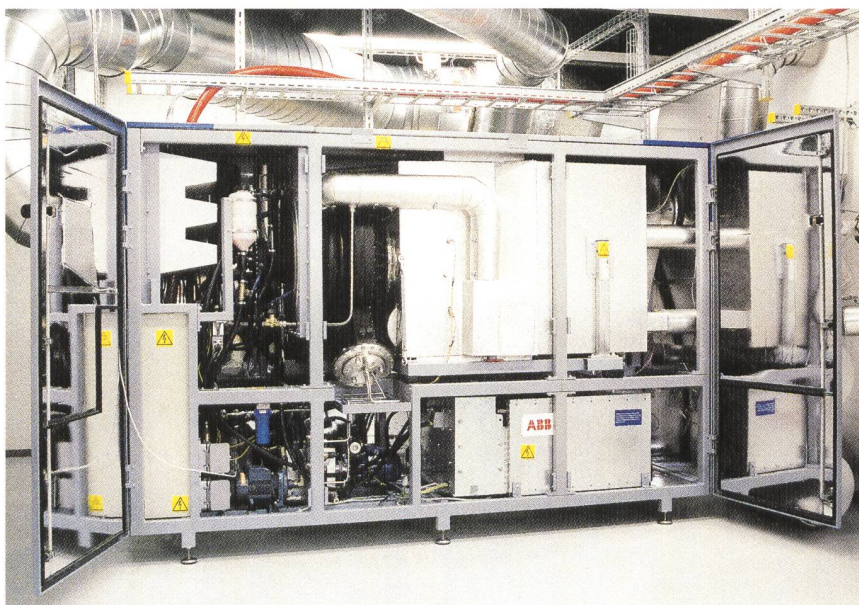
Bild 3 Innenleben der Mikroturbine: Mikroturbine (links), Wärmetauscher (oben rechts) und Leistungselektronik (unten rechts).
