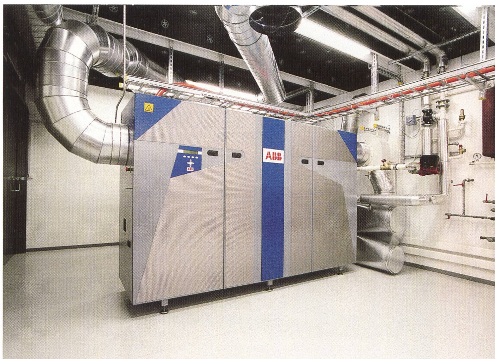
Bild 1 Erste als Kraft-Wärme-Kopplungs-Anlage (KWK) funktionierende Mikroturbine im ABB-Forschungszentrum Baden-Dättwil.
