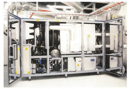
Bild 3 Innenleben der Mikroturbine: Mikroturbine (links), Wärmetauscher (oben rechts) und Leistungselektronik (unten rechts).
