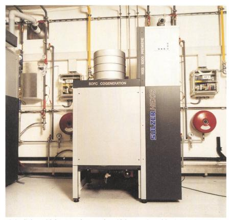
Mit dem liechtensteinischen Unternehmen Hoval entwickeltes Vorserienprodukt – bestehend aus 200-Liter-Wärmespeicher, 1-kW-Zellenstapel und Zusatzbrenner.
