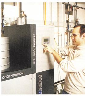
Konfiguration des Brennstoffzellensystems durch Elektroingenieur Andreas Rüegge.
