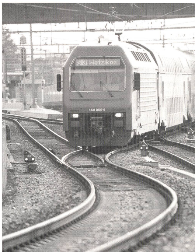
Bild 1 Gleisanlage im Bahnhof Effretikon (Quelle: IBB AG)
