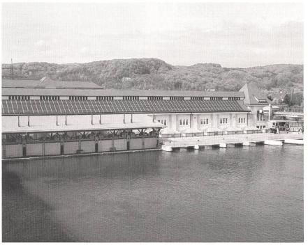
Das Rheinkraftwerk Whylen verfügt über eine installierte Leistung von 38,5 Megawatt. Im April 1999 wurde auf dem Dach zusätzlich eine Photovoltaikanlage mit einer Fläche von über 720 Quadratmetern (Leistung 70 Kilowatt) errichtet. Alleiniger Abnehmer ist die NaturEnergie AG.
