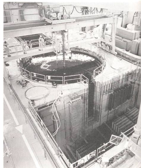
Im Innern des KKM: geflutete Reaktorgroble mit Brennelement-Lagerbecken.
