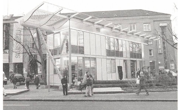
Minergie-Zukunftshaus «Phoenix» (Foto F. Beyeler).
