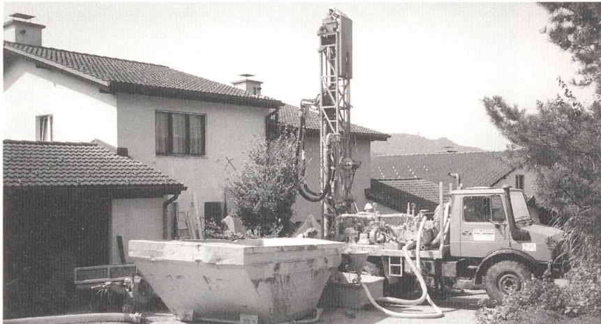
Bohrarbeiten für das Verlegen von Erdsonden für eine Wärmepumpenanlage.
