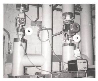
Bild 7 Feldtestpumpe (A) in Heizungsverteiler im Testbetrieb
