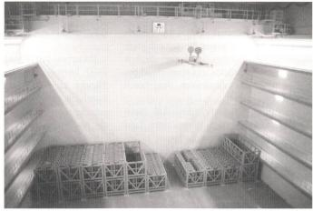
knapp 1000 m³ umfassenden Lagerbestandes an radioaktiven Betriebsabfällen im Kernkraftwerk Beznau. Fotos: NOK
