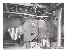
Schieber der Wasserdruckleitung.
