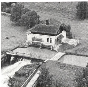
Hohe Investitionsvolumen für Kleinwasserkraftanlagen.
