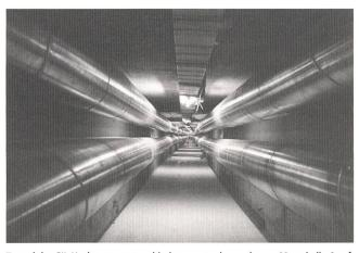
Tunnel der GIL-Hochspannungsverbindung unter der geplanten Messehalle 6 auf dem Palexpo-Gelände in Genf im Oktober 2000
