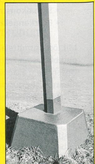
Betonschutz an Mastsockeln
