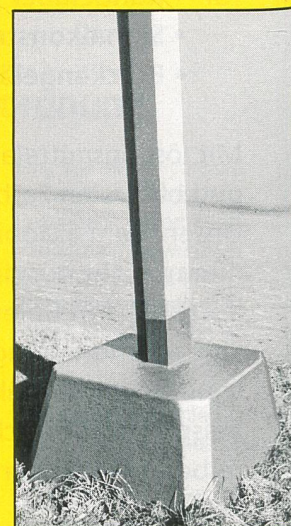
Betonschutz an Mastsockeln
