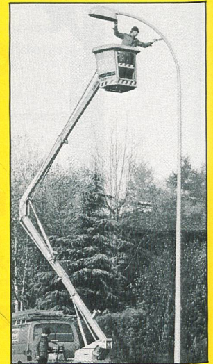
Korrosionsschutz an Stahlkandelabern
