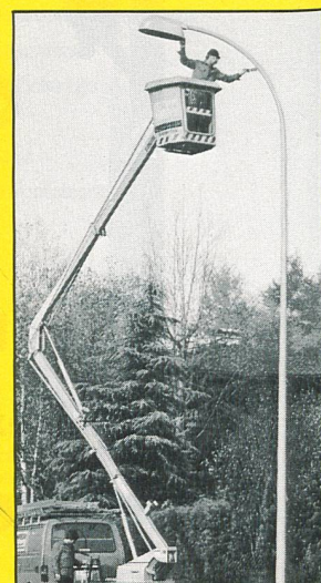
Korrosionsschutz an Stahlkandelabern
