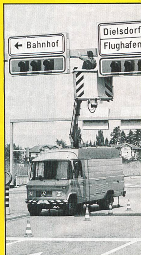
Korrosionsschutz an Signalanlagen
