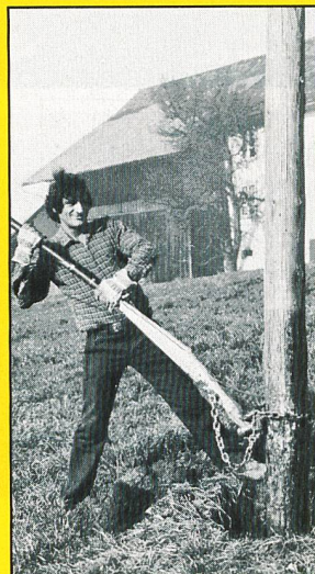
Nachimprägnierung von Holzmasten
