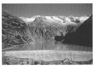
Der Gelmersee mit der 1929 fertiggestellten Gewichtsmauer ging als erster Speichersee der KWO in Betrieb.
