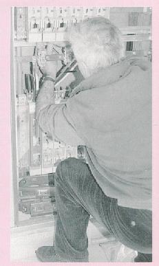
Unter Spannung stehende Teile abdecken / Recouvrir les pièces sous tension
