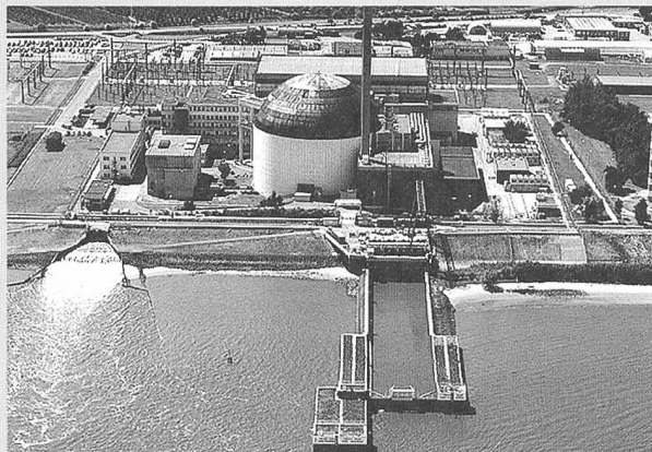
Das Kernkraftwerk Stade (672 MW) bei Hamburg soll im Jahr 2003 abgeschaltet werden.
