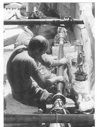
Trassenschächte der Elektrizitätsversorgungsunternehmen: viel freier Platz für Telekomanbieter.
