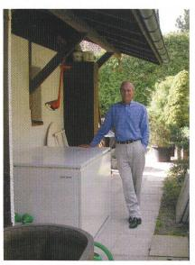
Bild 3 Luft/Wasser-Wärmepumpe, aussen aufgestellt.
