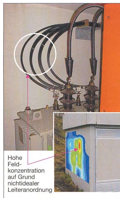
Bild 3 Ungünstige Leiteranordnung beim Sekundärabgang
