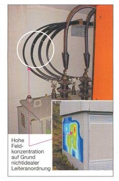
Bild 3 Ungünstige Leiteranordnung beim Sekundärabgang
