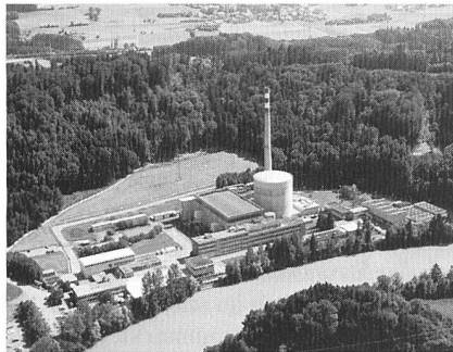
Wieder bereit für eine sichere, wirtschaftliche und umweltfreundliche Stromproduktion: das Kernkraftwerk Mühleberg. Foto: BKW
