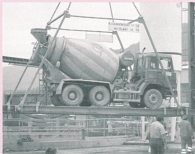
Oben: Blick in einen der beiden 30 m tiefen Angriffsschächte. – Rechts: Soeben wird ein Frischbeton-Lastwagen aus dem Angriffsschacht herausgehoben.
