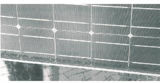
Bild 6 Moduloberfläche mit Algenbildung an der unteren Kante
