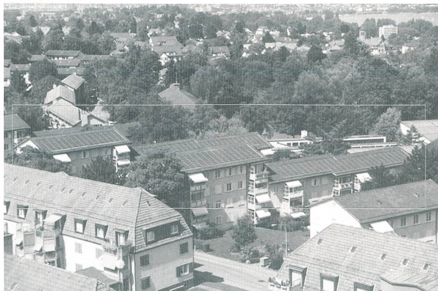
Bild 4 53-kWp-Solaranlage ABZ, Zürich
