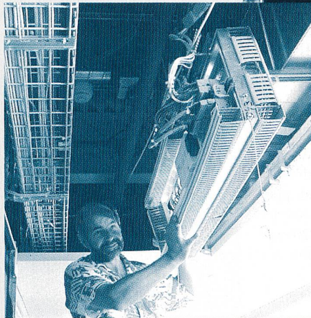
Fig. 3 Composants du LON dans le faux-plafond d'un corridor (Source BUS-House)
