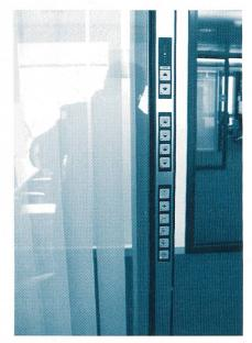
Fig. 2 Clavier sous membrane pour la commande intégrale de tous les appareillages (Source BUS-House)
