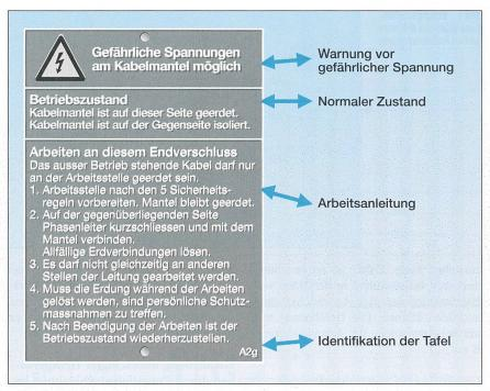
Bild 6 Warntafeln zur Verwendung bei einseitig geerdetem Kabelmantel
