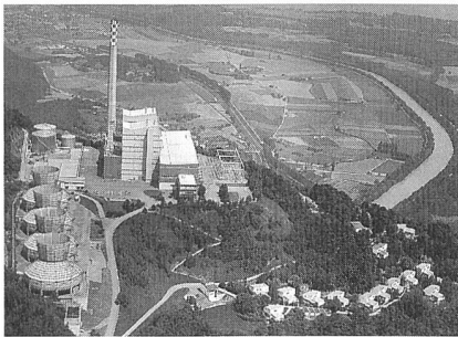
Das westschweizerische Wärmekraftwerk Chavalon.
