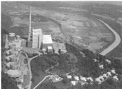
Das westschweizerische Wärmekraftwerk Chavalon.
